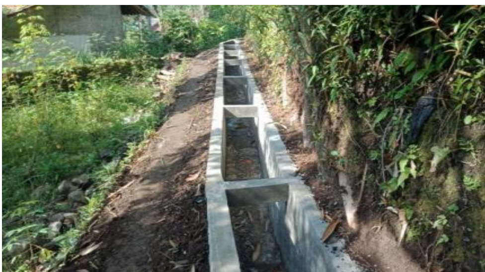
Rehabilitasi Jaringan Irigasi – DI Sunia
