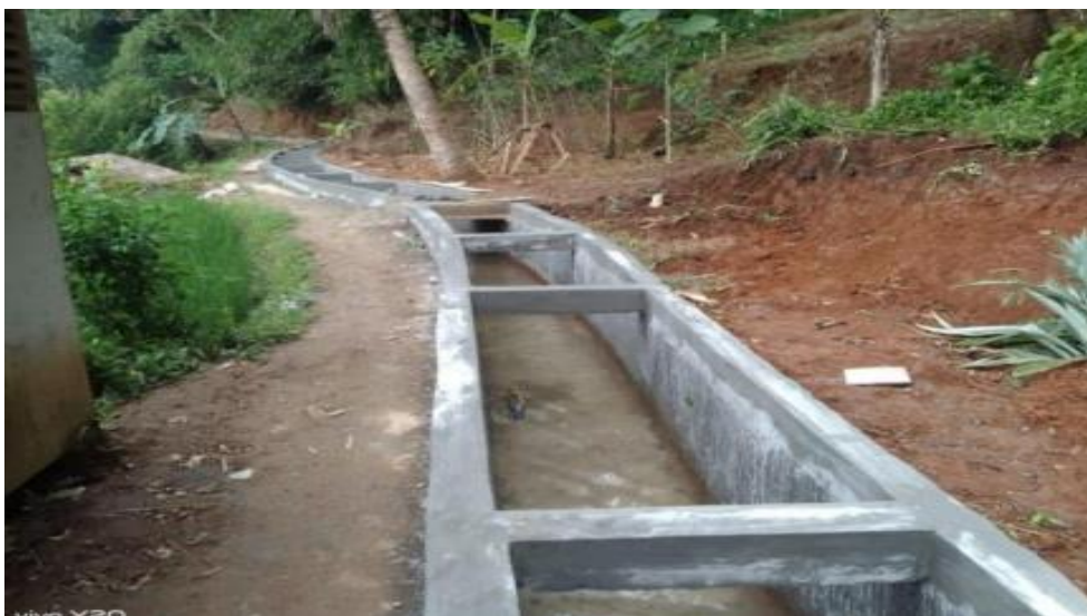
Rehabilitasi Jaringan Irigasi – DI Cirama
