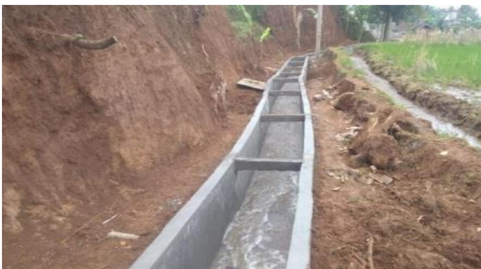
Rehabilitasi Jaringan Irigasi – DI Tanjung
