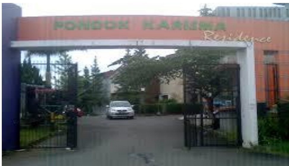
Peningkatan Prasarana, Sarana Dan Utilitas (PSU)- Pondok Karisma Residence
