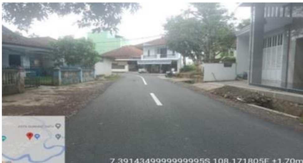
Pembangunan Jalan – Ruas Kudang - Cibutei
