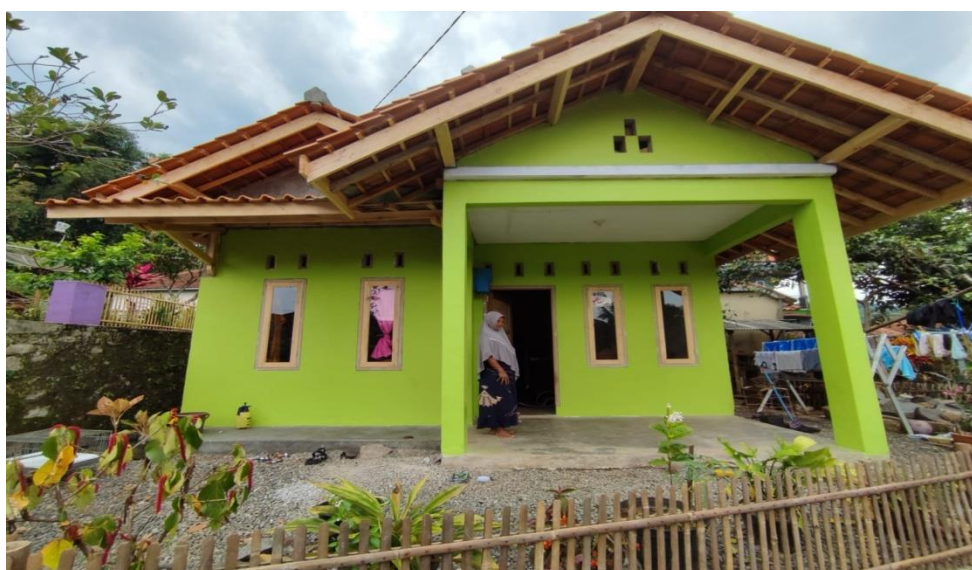
Rehabilitasi Rumah Tidak Layak Huni – Desa Kurniabakti Kecamatan Ciawi
