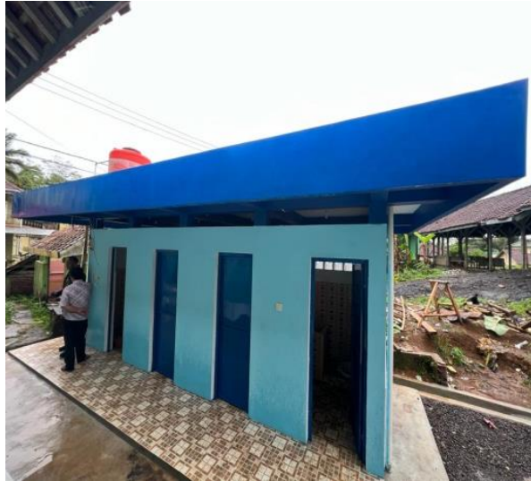
Pembangunan MCK Komunal - Desa Ciwarak Kecamatan Jatiwaras
