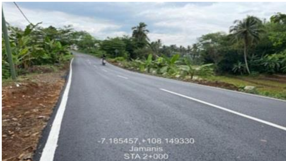
Pembangunan Jalan – Ruas Ciawi - Singaparna
