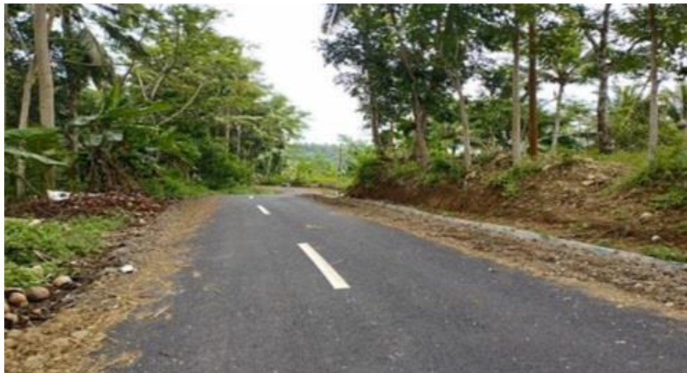
Pembangunan Jalan – Ruas Sindangreet - Cidadap
