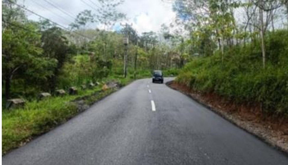
Pembangunan Jalan – Ruas Papayan - Cikalong
