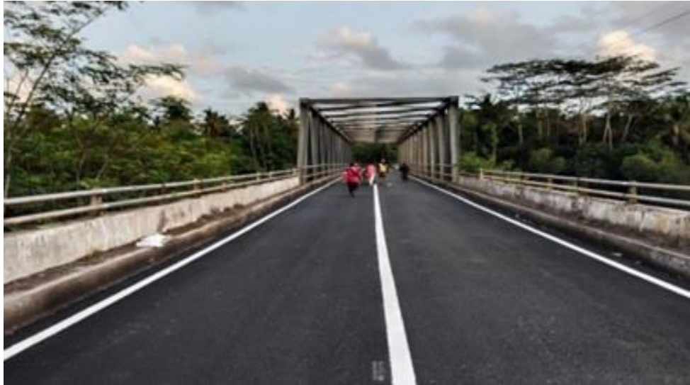
Pembangunan Jalan – Ruas Ciwatin - Kalapagenep
