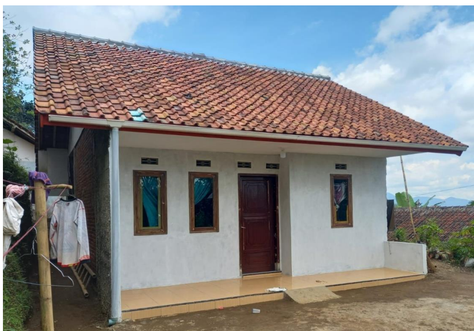
Rehabilitasi Rumah Tidak Layak Huni – Desa Sukamukti Kecamatan Cisayong
