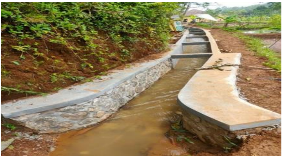
Rehabilitasi Jaringan Irigasi – DI Cibaeud
